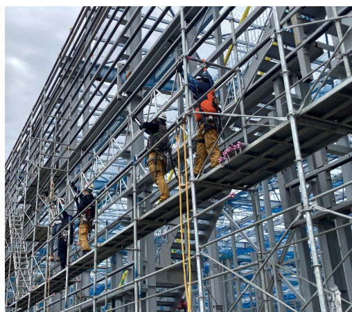
②事前組み立てした梁枠4スパンを 支柱に設置
