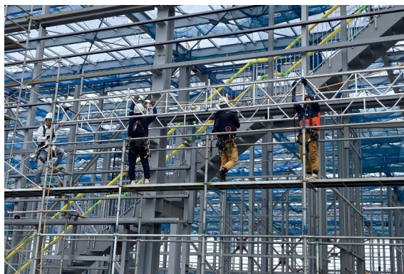
③手すりの設置
