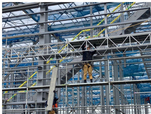
④鋼製布板の設置
